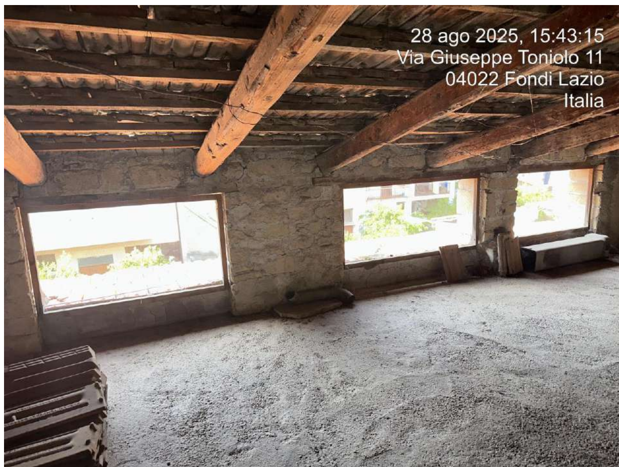
FOTO 29 – SOFFITTA (PIANO SECONDO)
