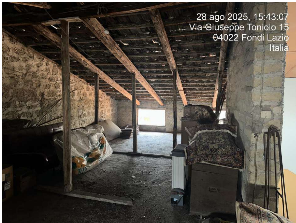
FOTO 28 – SOFFITTA (PIANO SECONDO)
