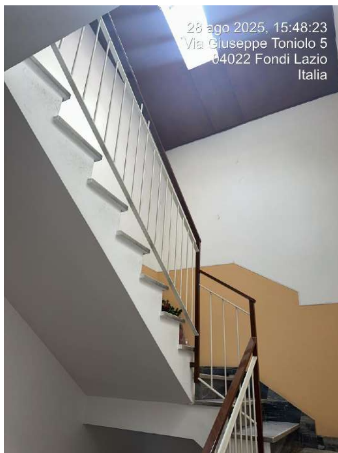
FOTO 12 – VANO SCALA COMUNE
